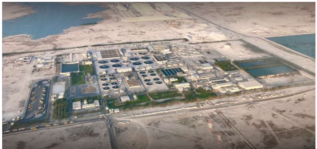
Station d'épuration de Doha West – Traitement des eaux résiduaires urbaines – opérée par Suez - Qatar
