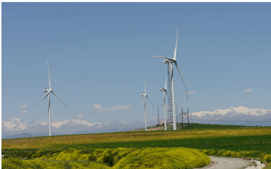
Site éolien à Gori
