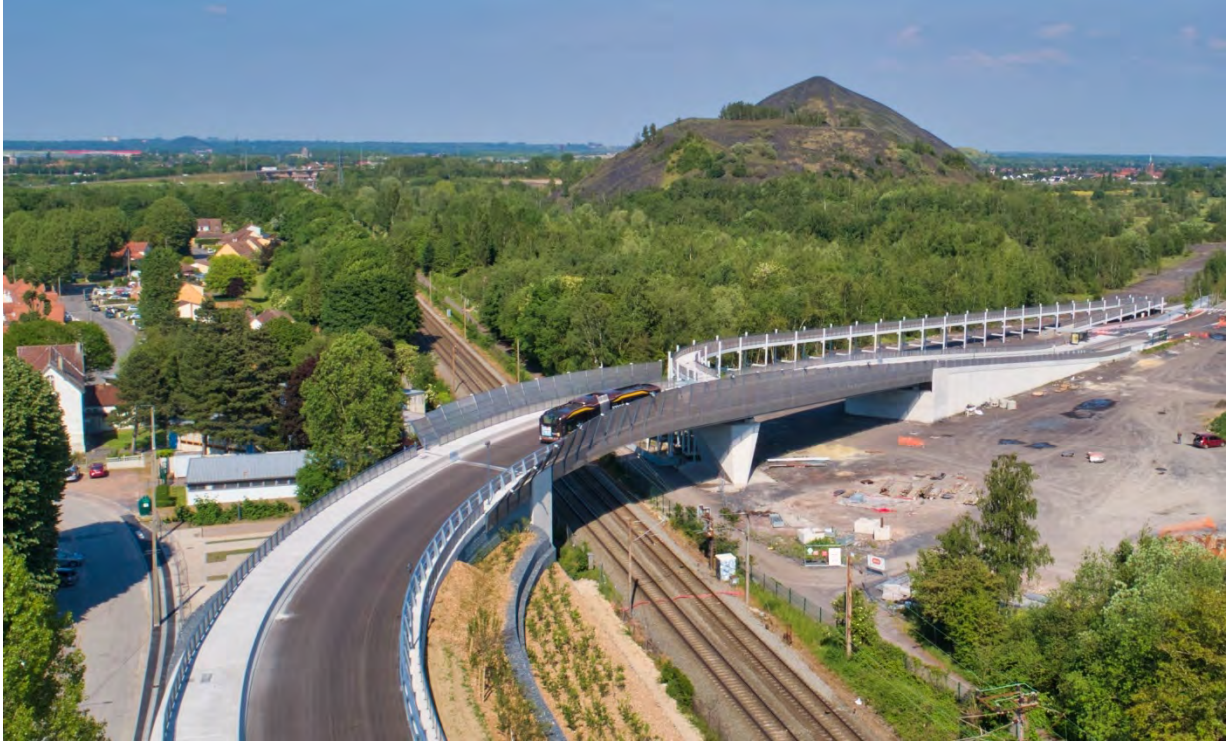
Pasarela D2 en La Défense
